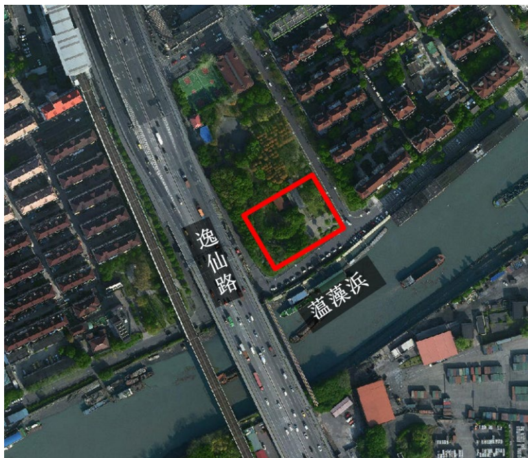
图5-93 规划吴淞雨水泵站选址现状用地情况
