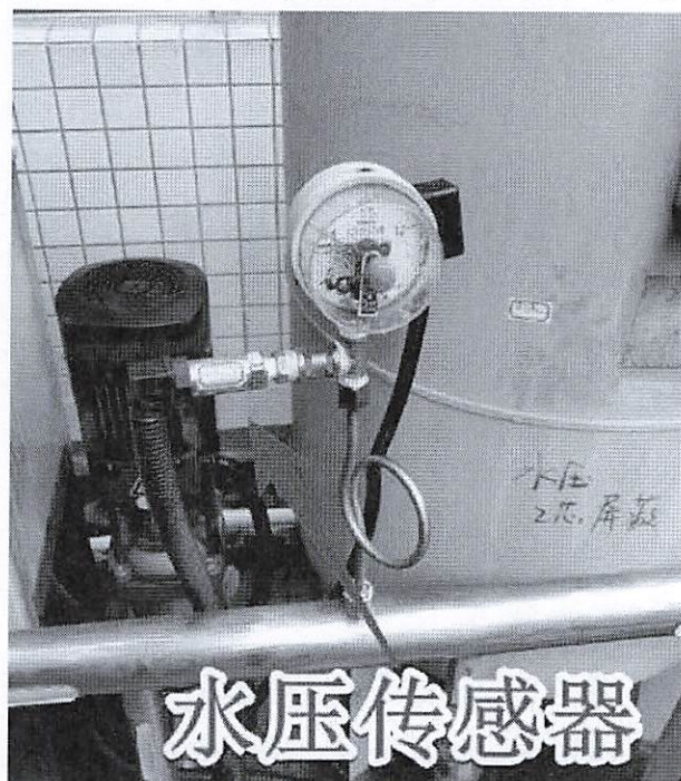
图 26 喷淋水压安装示例
